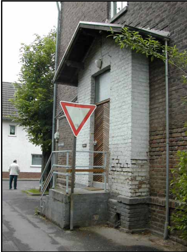
Eingang zur Lehrerwohnung vorher
