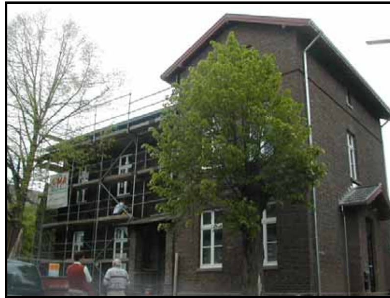
während der Fassadensanierung
